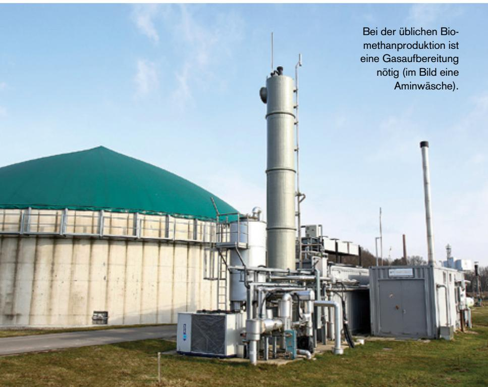
Bei der üblichen Biomethanproduktion ist eine Gasaufbereitung nötig (im Bild eine Aminwäsche).
