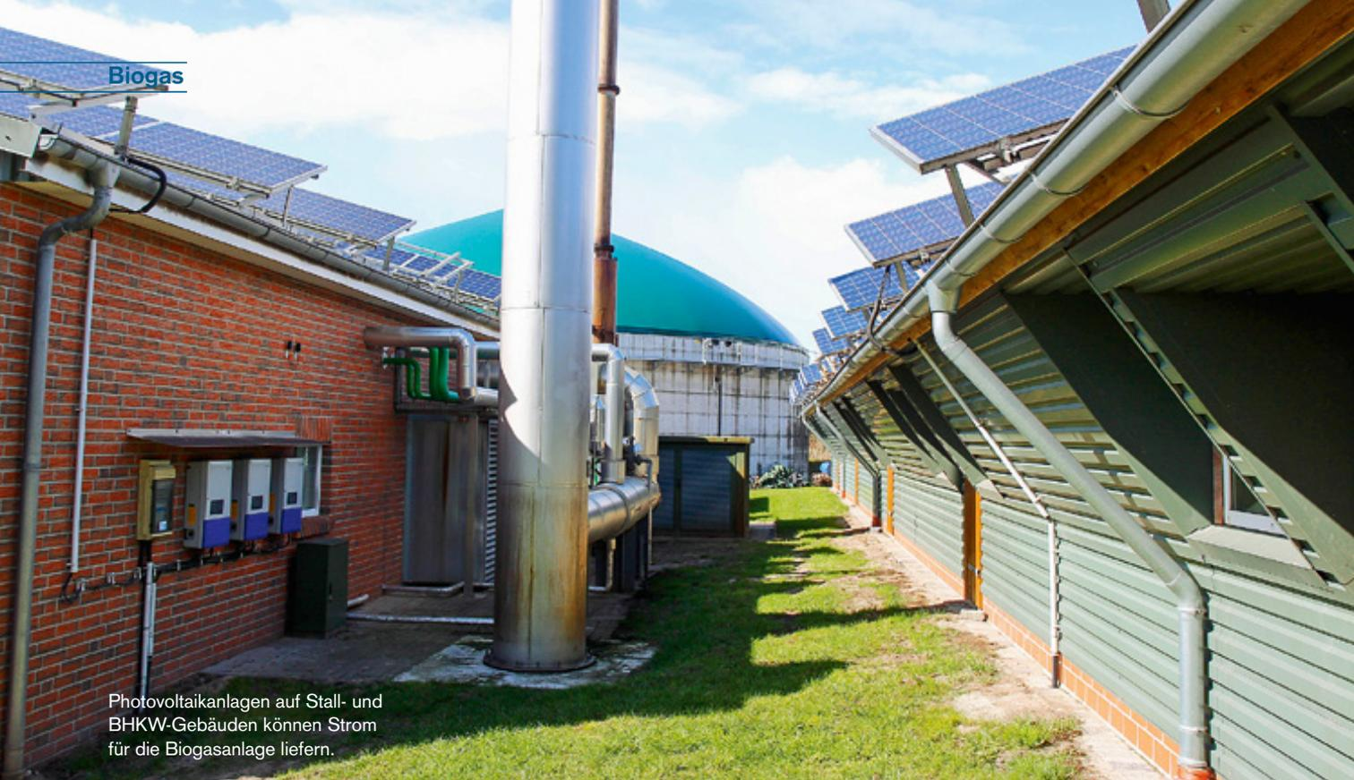
Photovoltaikanlagen auf Stall- und BHKW-Gebäuden können Strom für die Biogasanlage liefern.
