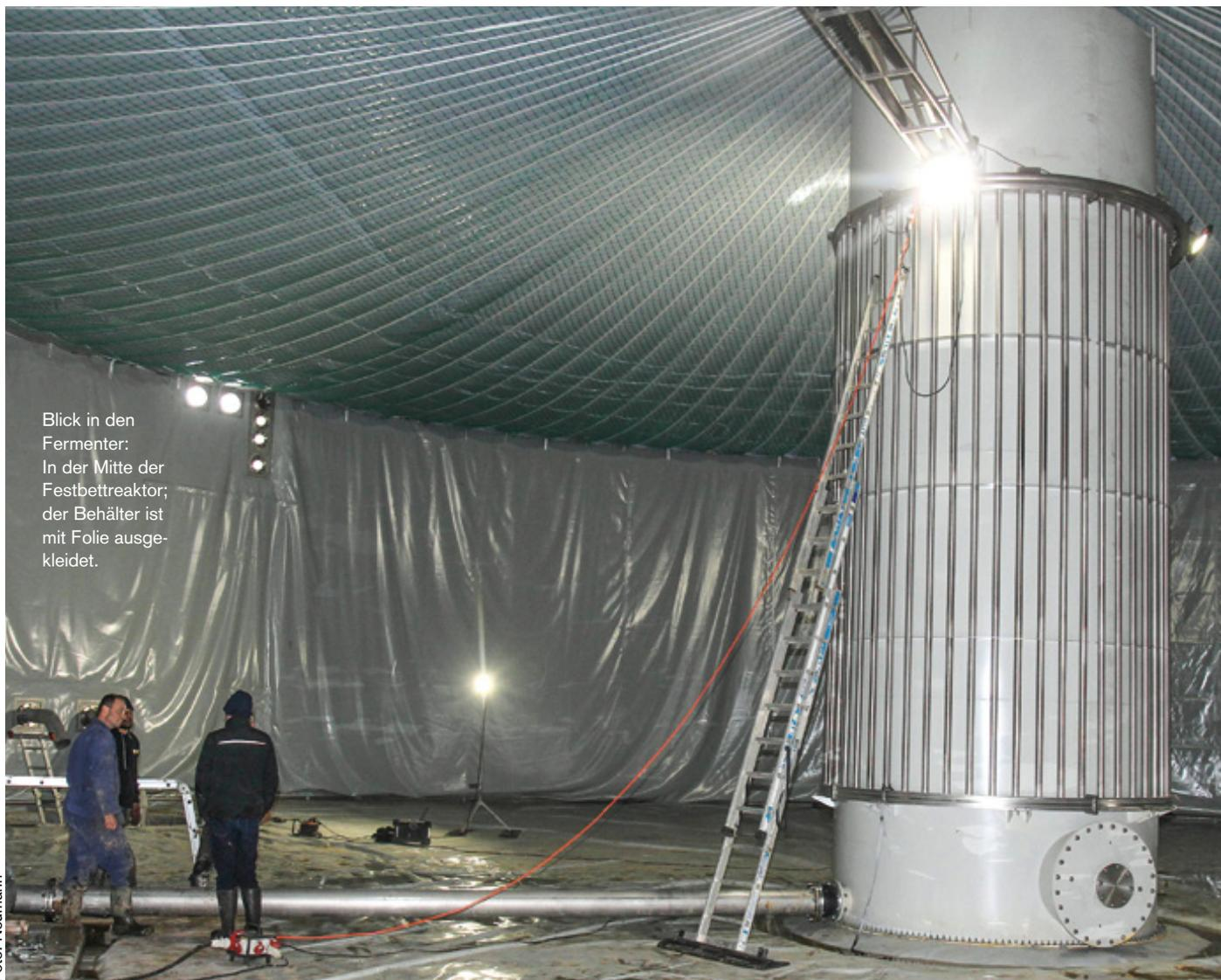
Blick in den Fermenter: In der Mitte der Festbettreaktor; der Behälter ist mit Folie ausgekleidet.
